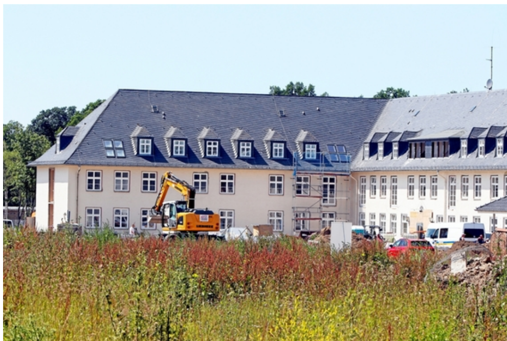
Bagger im Einsatz: An den früheren Kompanie-Unterkünften wird kräftig gewerkelt.
